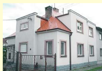
Velký RD Kostelec nad Orlicí
