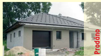
Nedokončená novostavba RD, Nahořany
